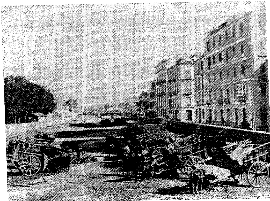
Una parada de carretas, con sus bueyes, en el cauce del río. A la izquierda, la entonces frondosa arboleda del Pasillo de Santo Domingo y, al fondo, el antiguo puente, el que unos años después destruyó la riada de 1907
